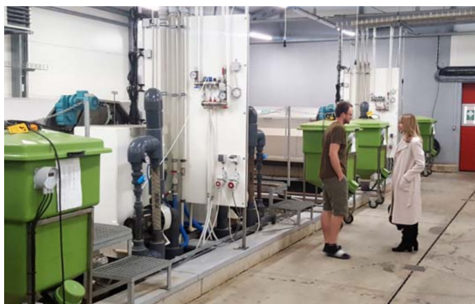
Výroba ryb probíhá v moderní hale s recirkulačním systémem využívající energii odpadního tepla z bioplynové stanice.
